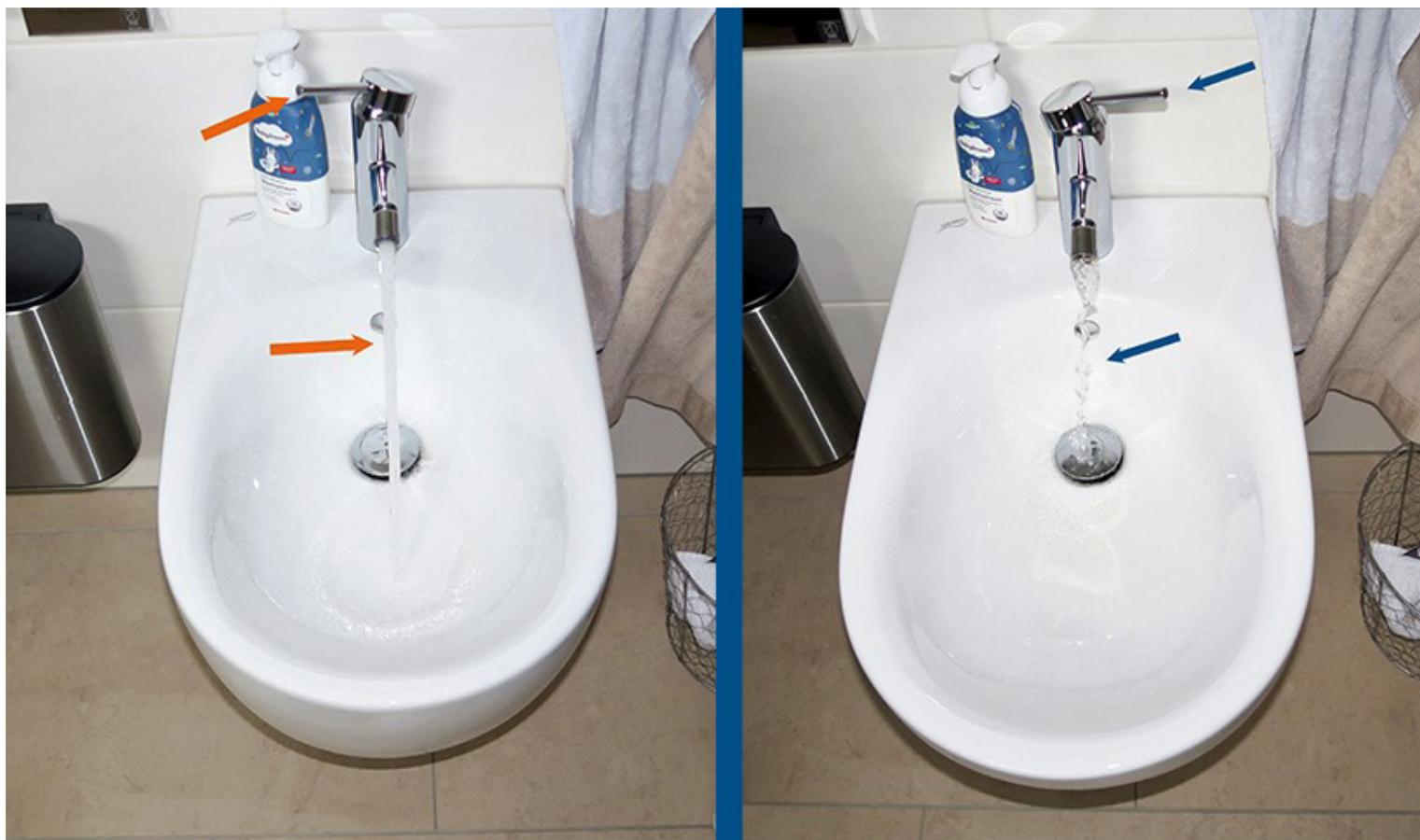
Die Aufnahmen rechts und in der Mitte zeigen das Bidet im Gäste-Bad. Bei der Entnahme von Kaltwasser (rechts) ist die maximale Entnahmerate erheblich reduziert, während sie bei Entnahme von Warmwasser (Mitte) in vollem Umfang zur Verfügung steht. Foto: [www.ifs-ev.org](http://www.ifs-ev.org).
