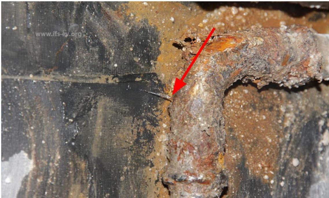
Korrodiertes Fitting mit Wasseraustritt (Pfeil) im geöffneten Bodenaufbau Foto: [www.ifs-ev.org](http://www.ifs-ev.org).
