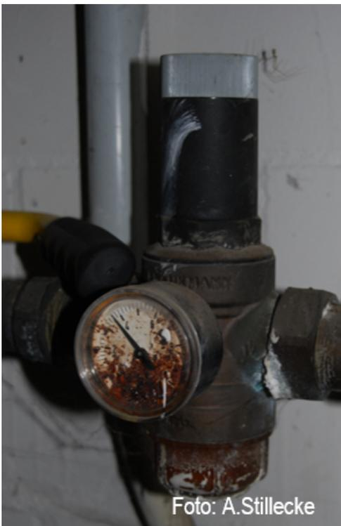
Ein solcher Druckminderer lässt auf eine nicht bestimmungsgemäß betriebene Trinkwasser-Installation schließen.
